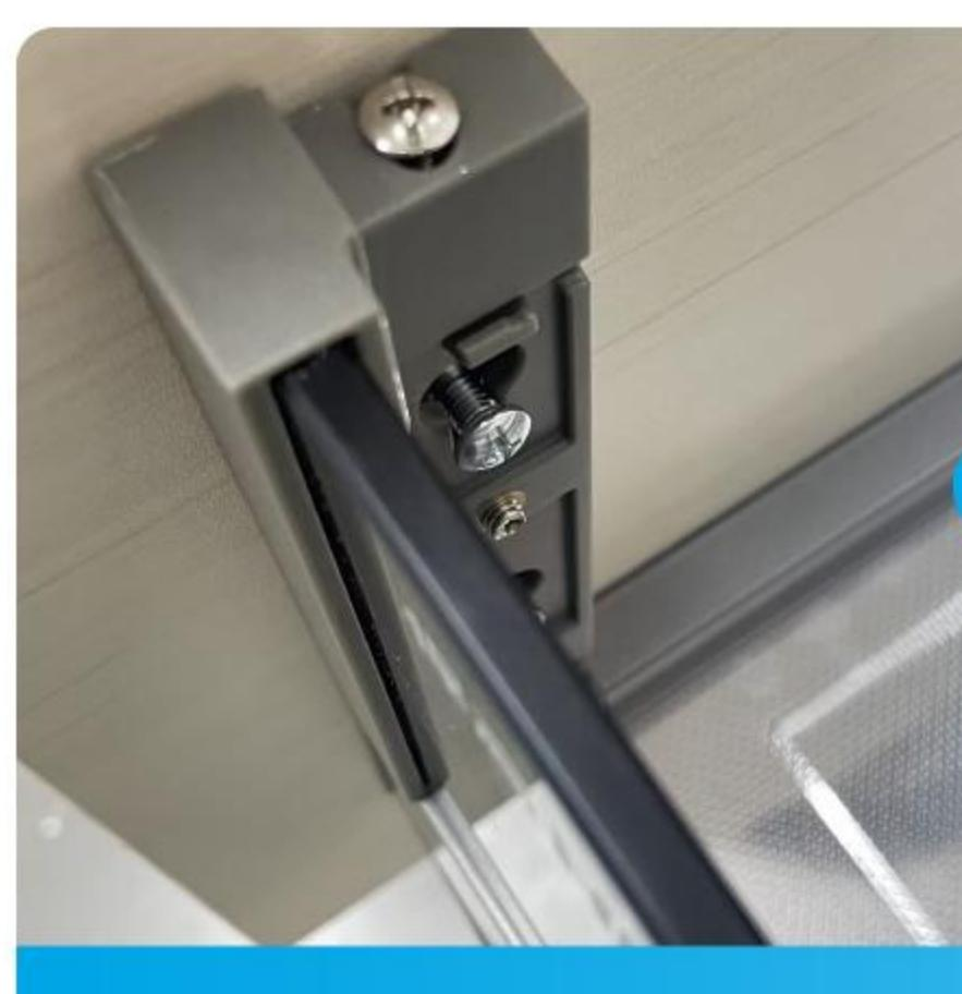
安装门板固定条，门板安装完成
