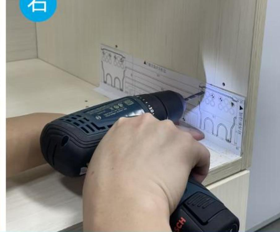
下层使用安装模板进行预钻孔（左/右）
