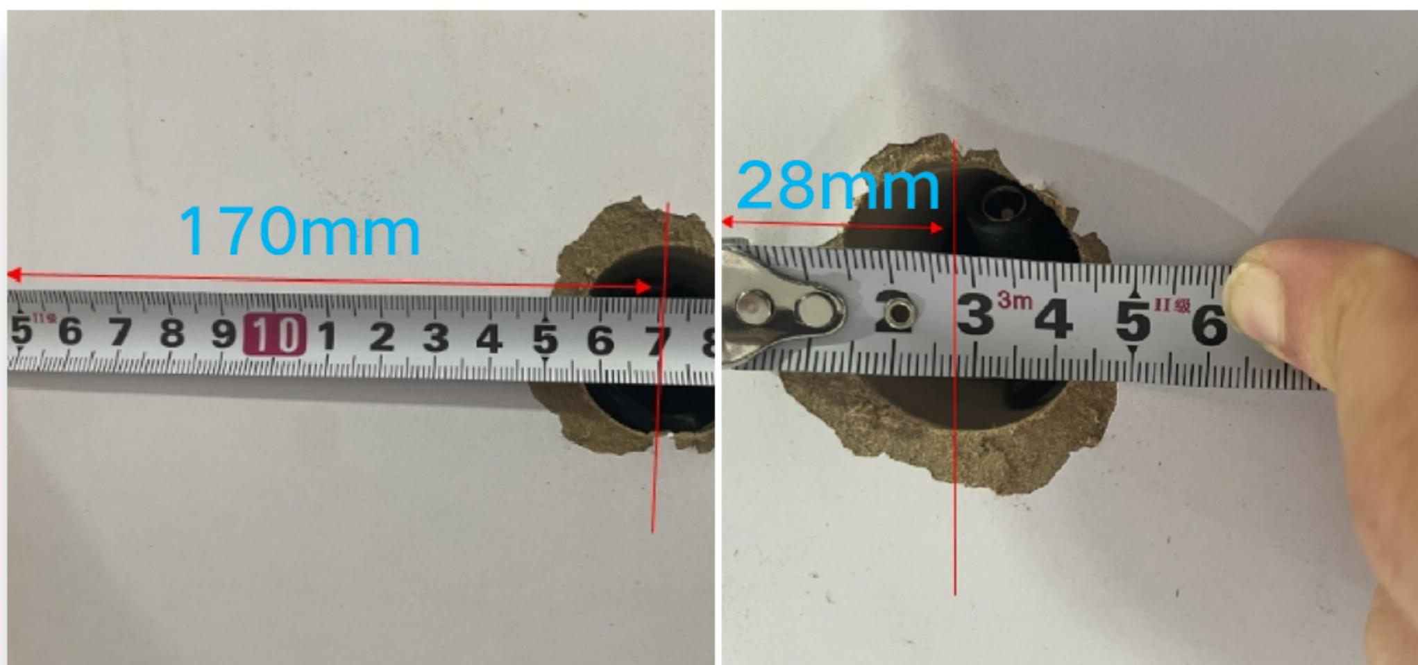
柜体顶板右开出线孔，底柜边到孔心距170mm，侧边柜到孔心距28mm
