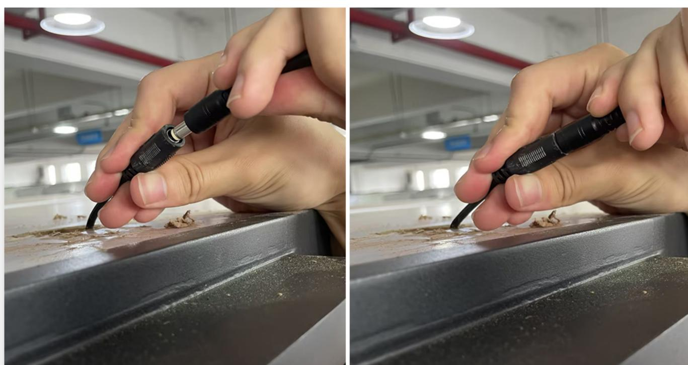
将电源插头从顶板右开孔引出，
