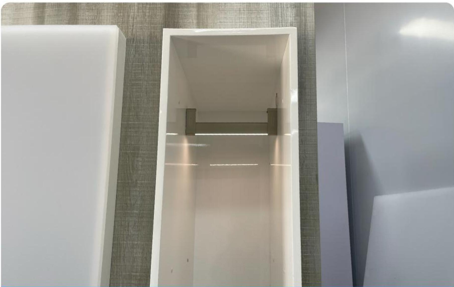
通电测试，柜内侧装挂衣杆灯安装完成
