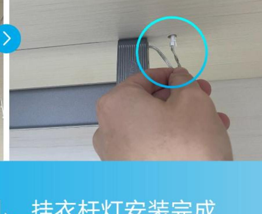
先将引线穿入电源线孔，挂衣杆灯安装完成
