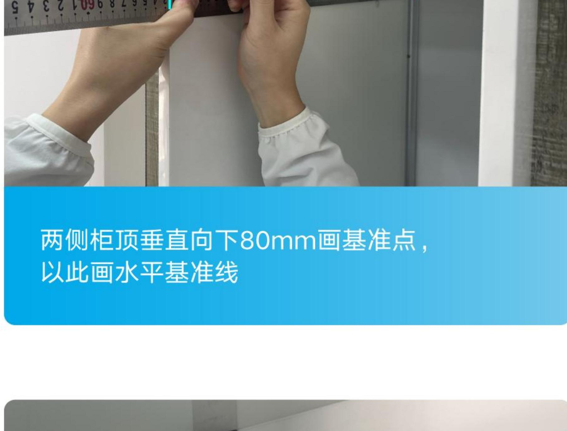
两侧柜顶垂直向下80mm画基准点，
