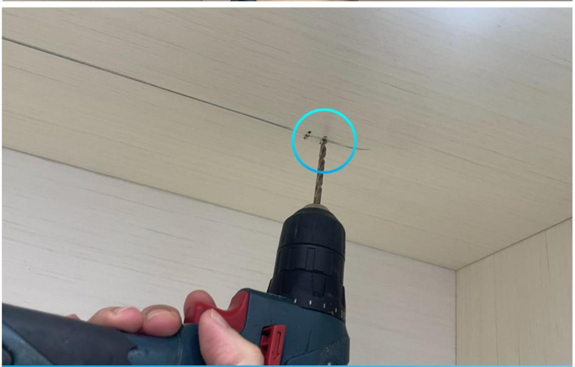
在定位点钻孔，孔径2.5mm\*4
