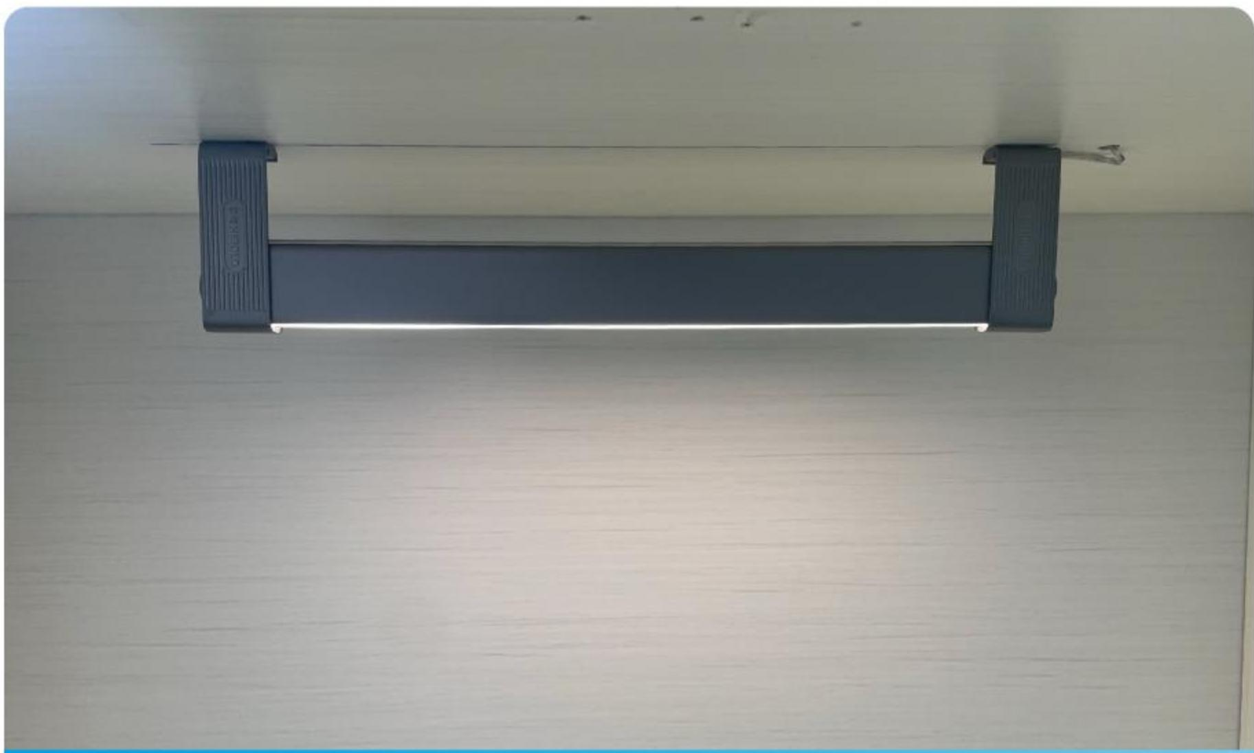
通电测试，柜内顶装挂衣杆灯安装完成
