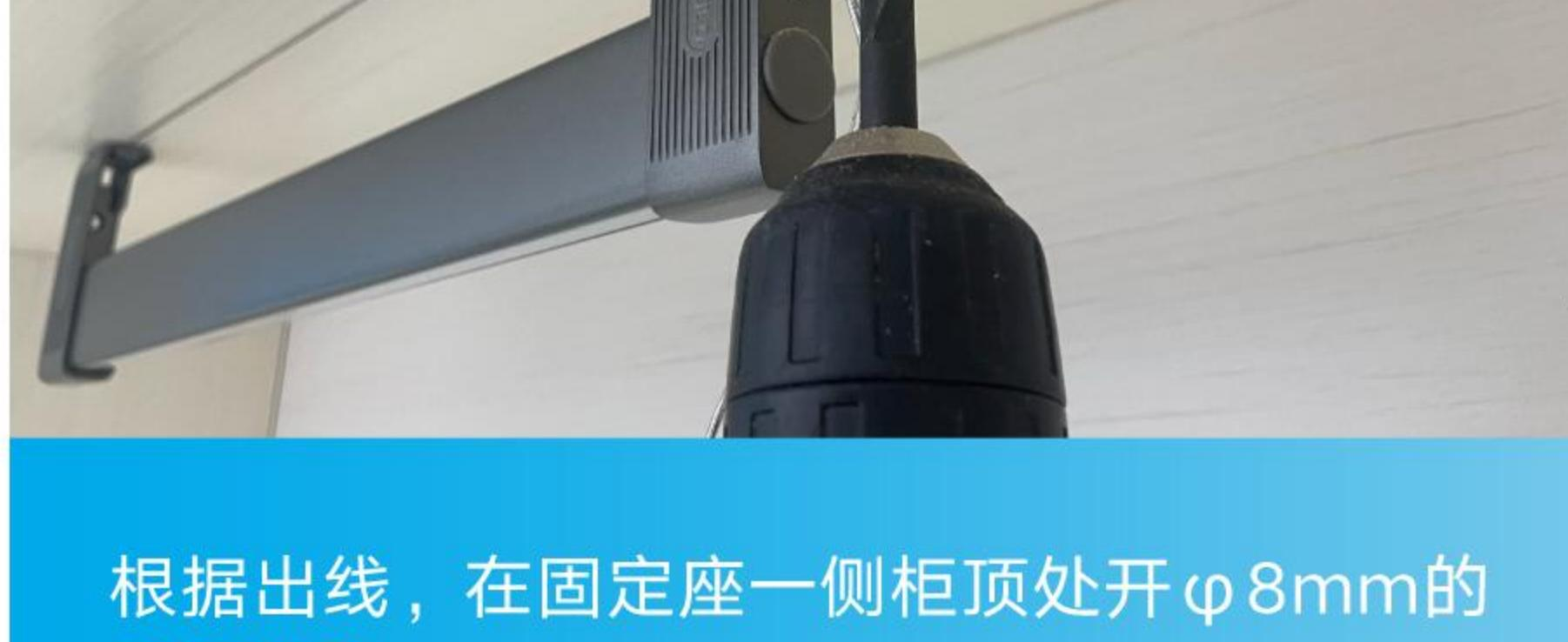
根据出线，在固定座一侧柜顶处开 $\varphi 8\text{mm}$ 的
