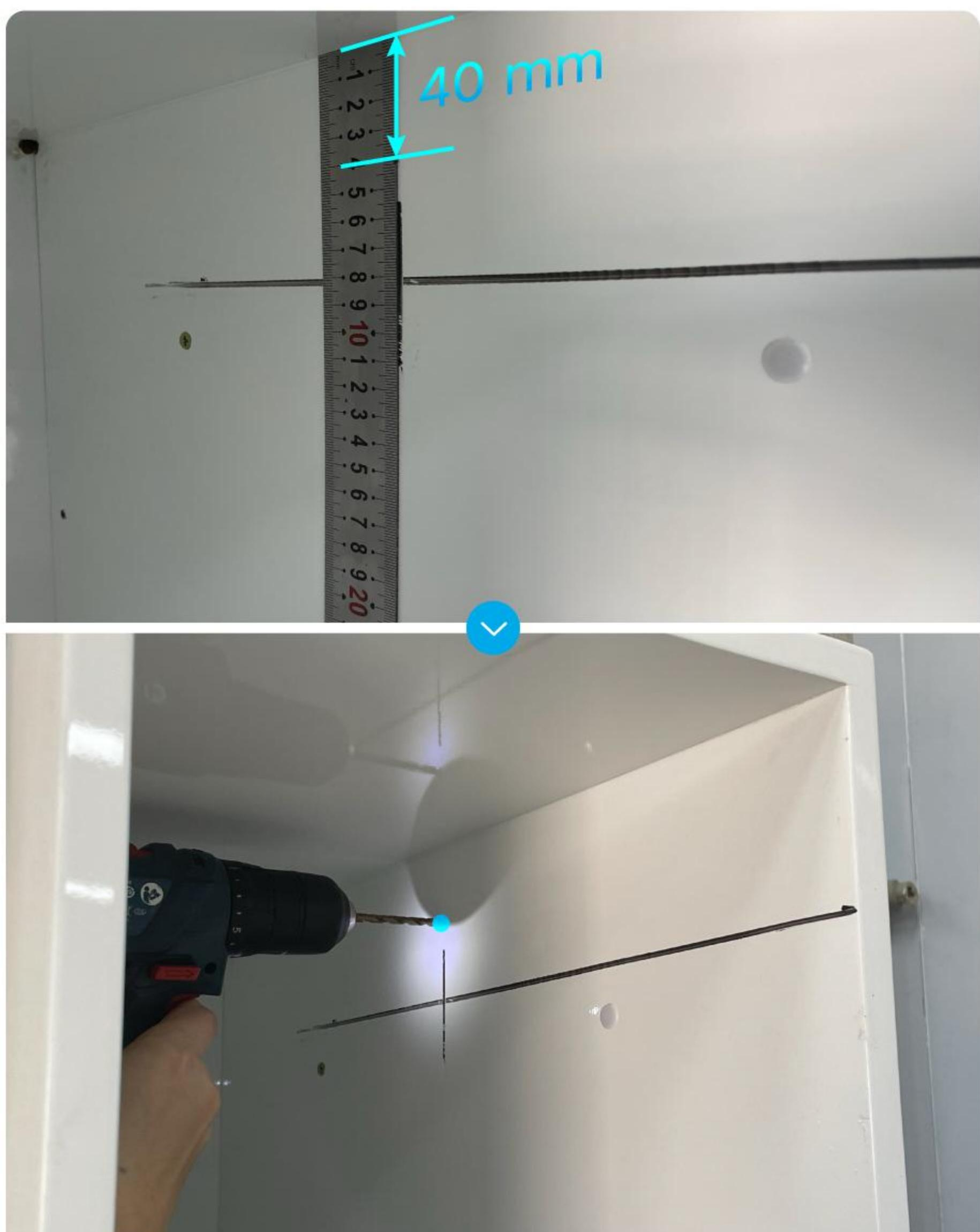
两侧在中点垂直直线距柜顶向下40mm画点，
