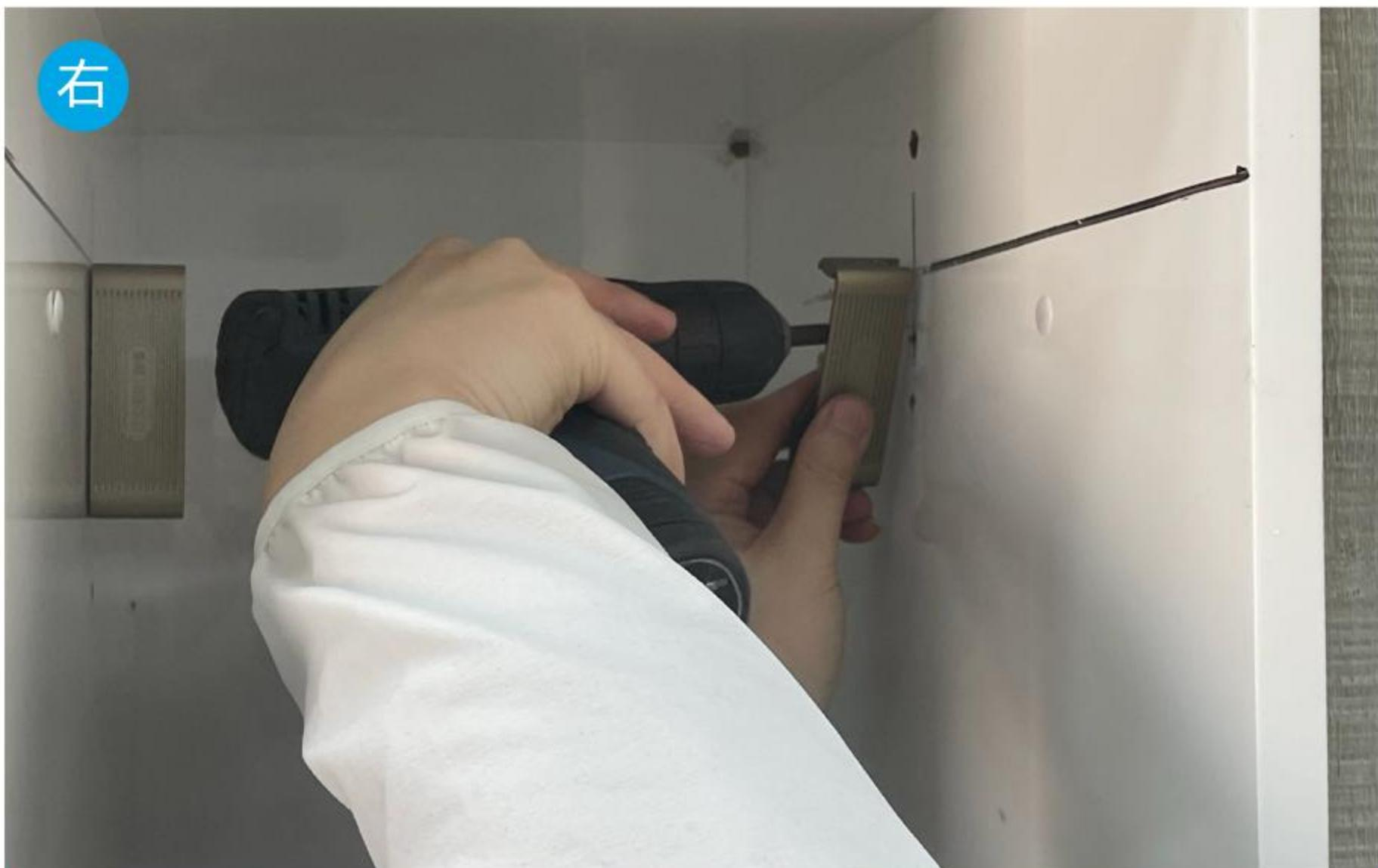
两侧以水平基准线为顶点，安装固定座，
