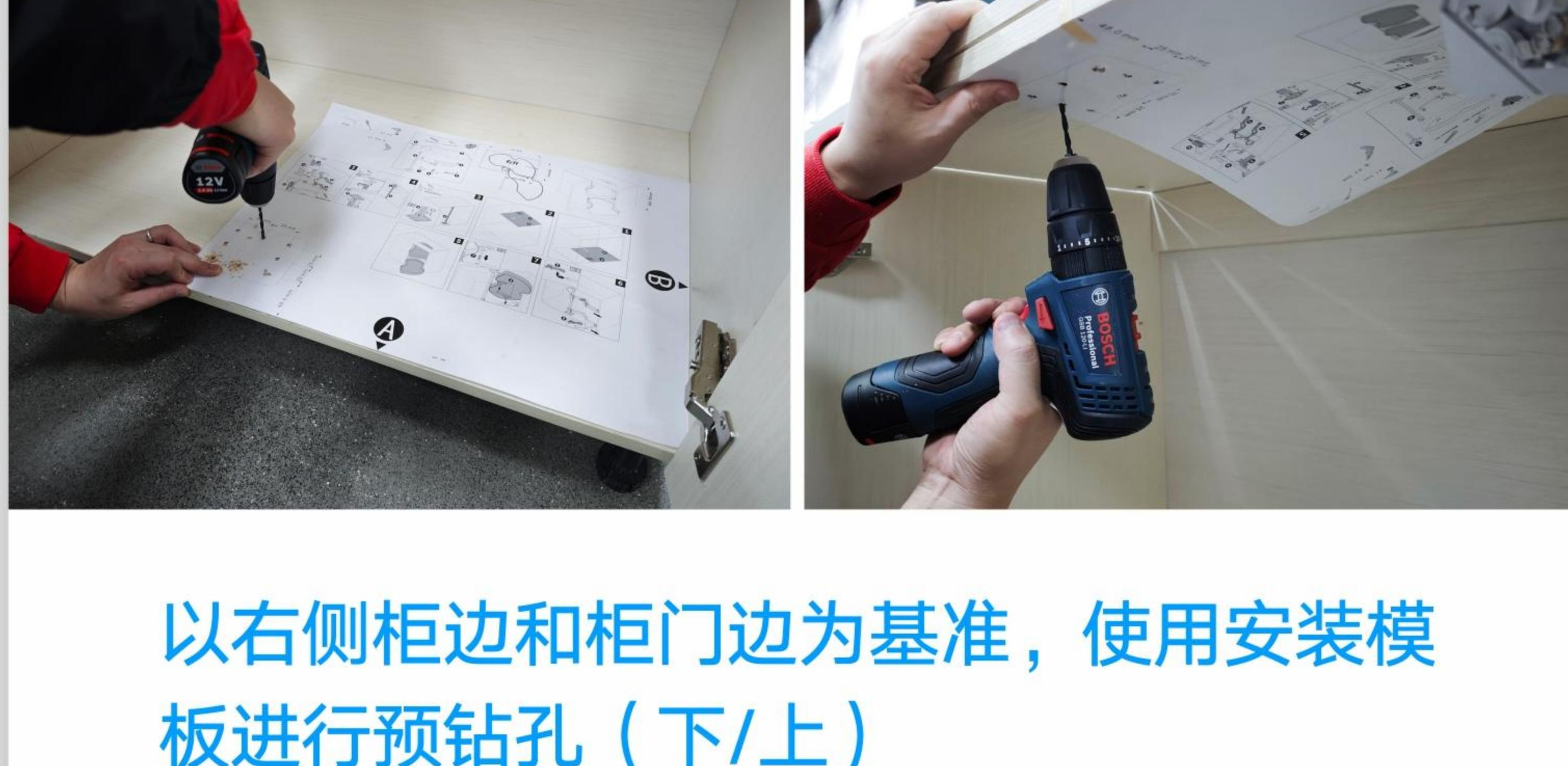
以右侧柜边和柜门边为基准，使用安装模板进行预钻孔（下/上）
