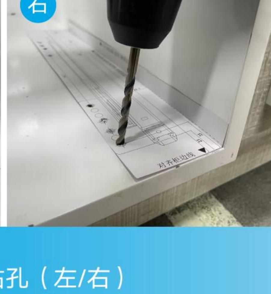
使用安装模板进行预钻孔（左/右）
