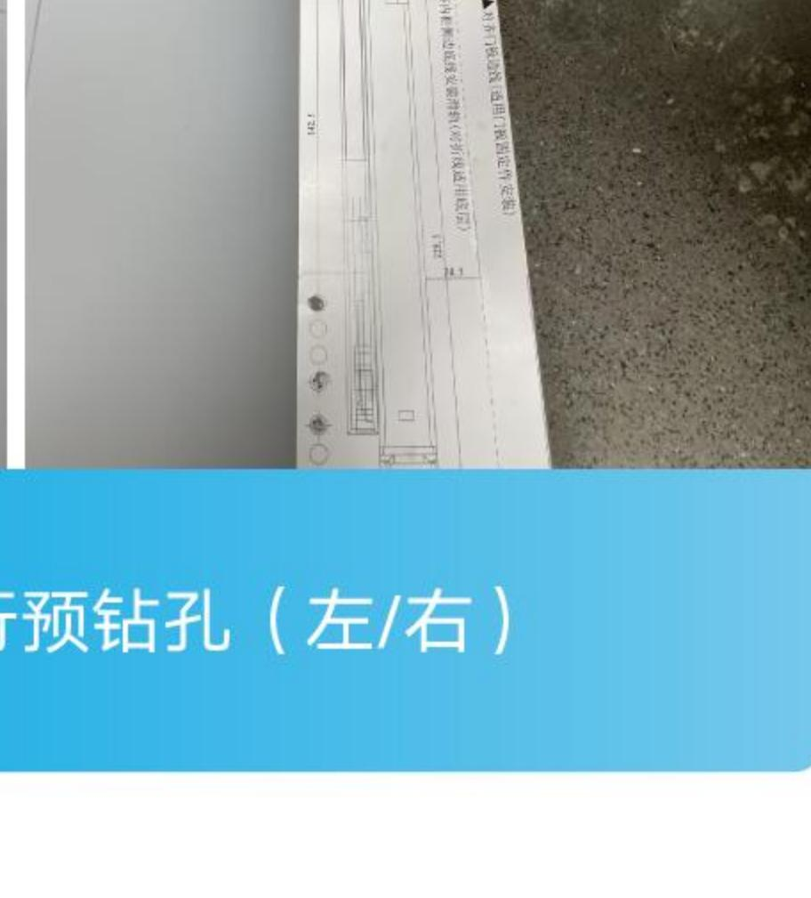
门板使用安装模板进行预钻孔（左/右）
