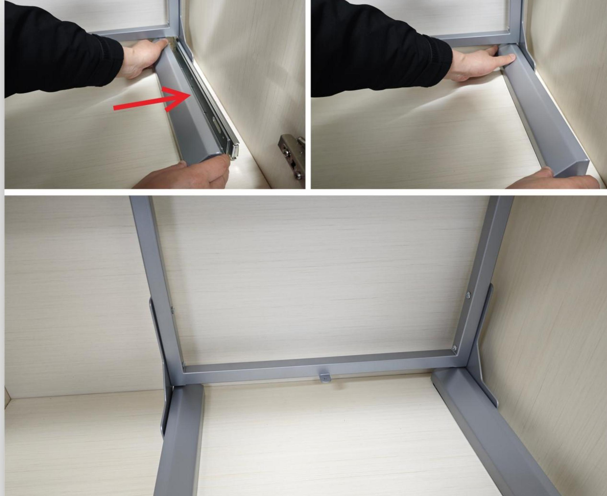
将导轨装饰盖对准导轨底部位置卡入（左/右），主体框架安装完成。
