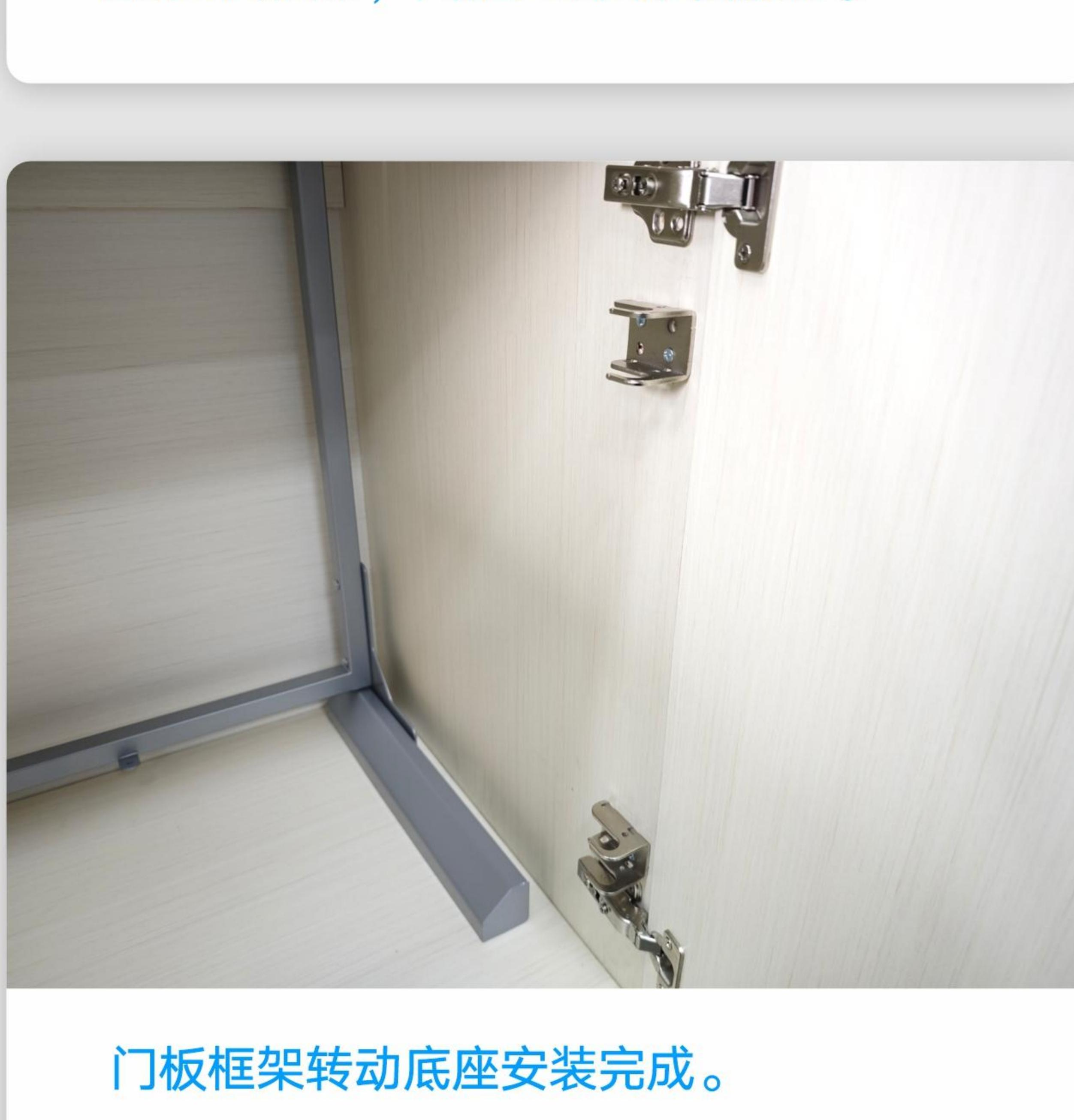
门板框架转动底座安装完成。
