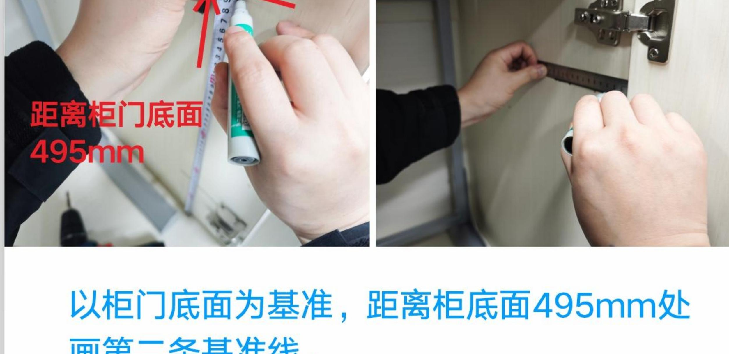
以柜门底面为基准，距离柜底面495mm处画第二条基准线。
