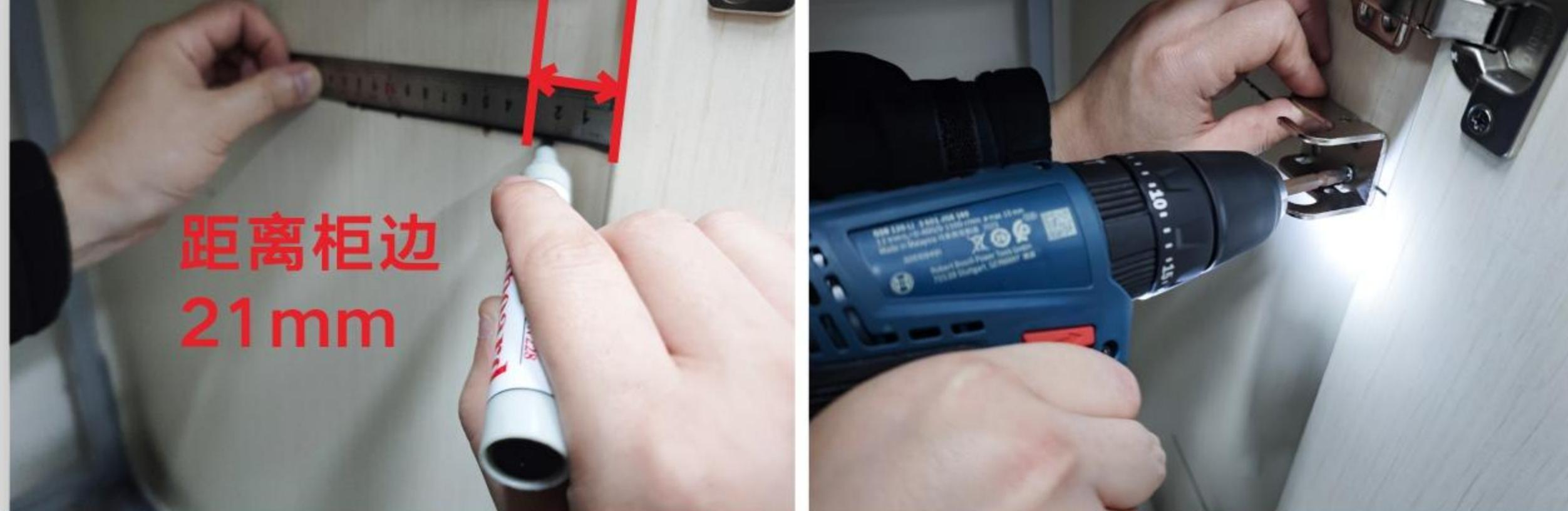
在第二条基准线上，距离柜边21mm处确定基准点，使用ST4.0\*16自攻螺钉对准基准点，固定上部转动底座。
