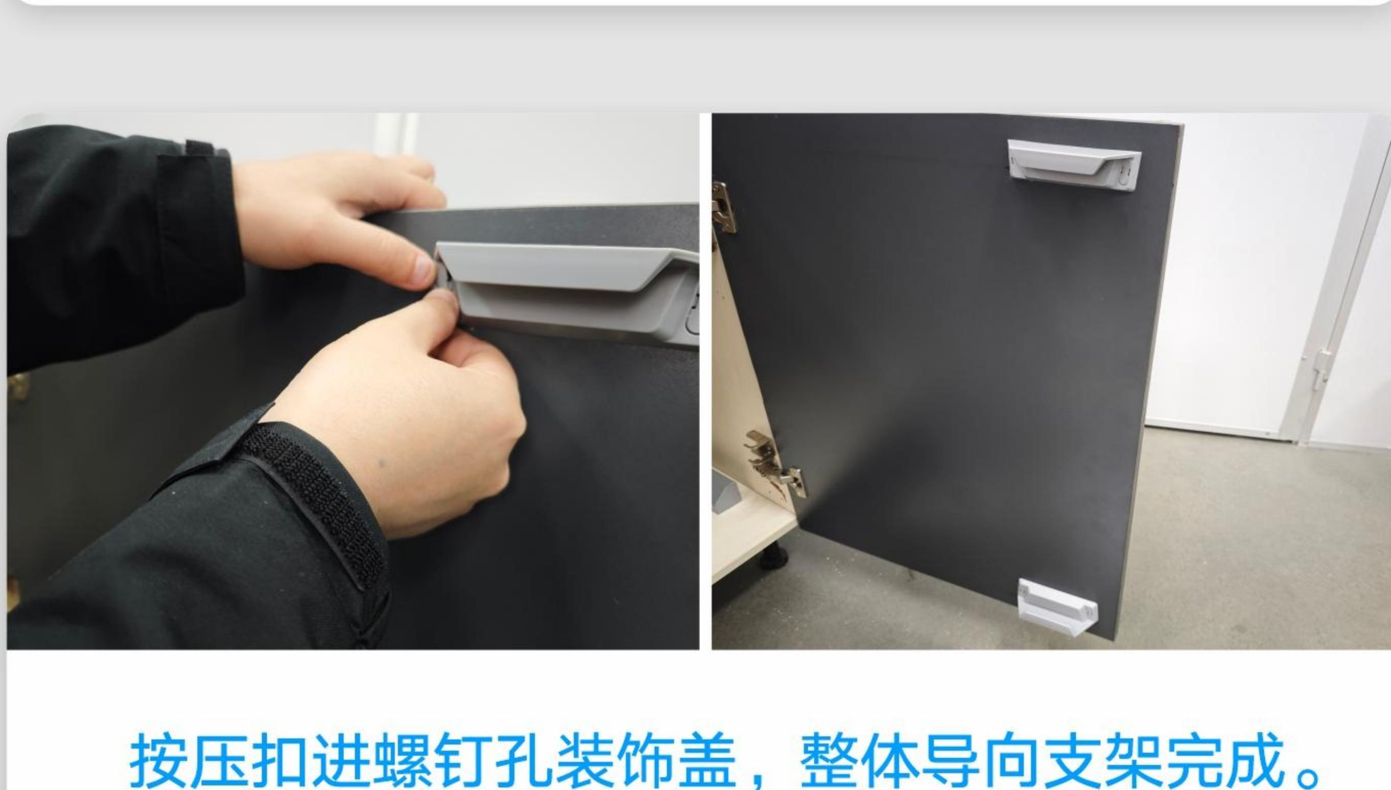
按扣进螺钉孔装饰盖，整体导向支架完成。
