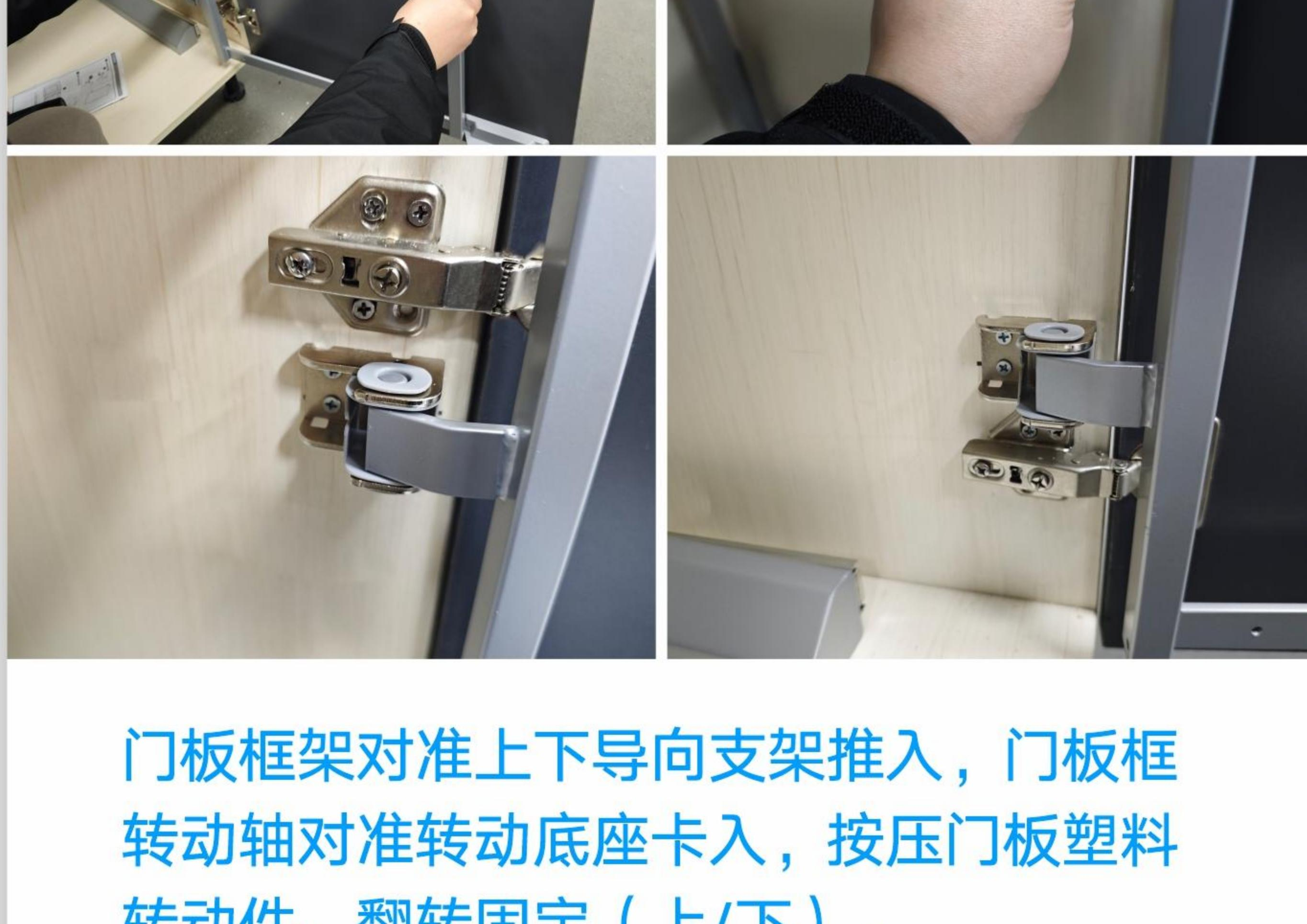
门板框架对准上下导向支架推入，门板框转动轴对准转动底座卡入，按压门板塑料转动件，翻转固定（上/下）。
