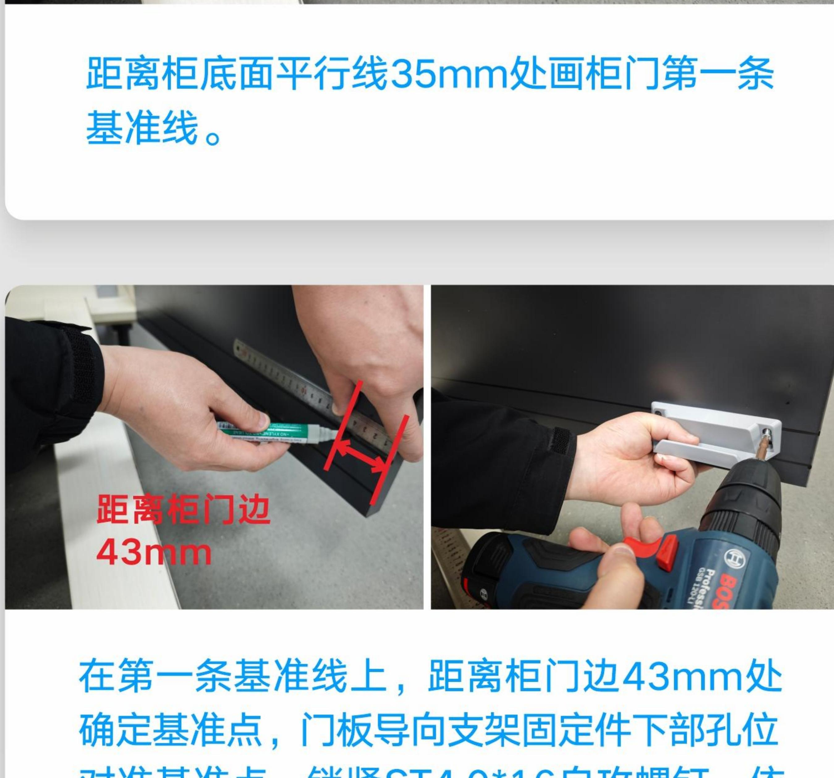
距离柜底面平行线35mm处画柜门第一条基准线。
