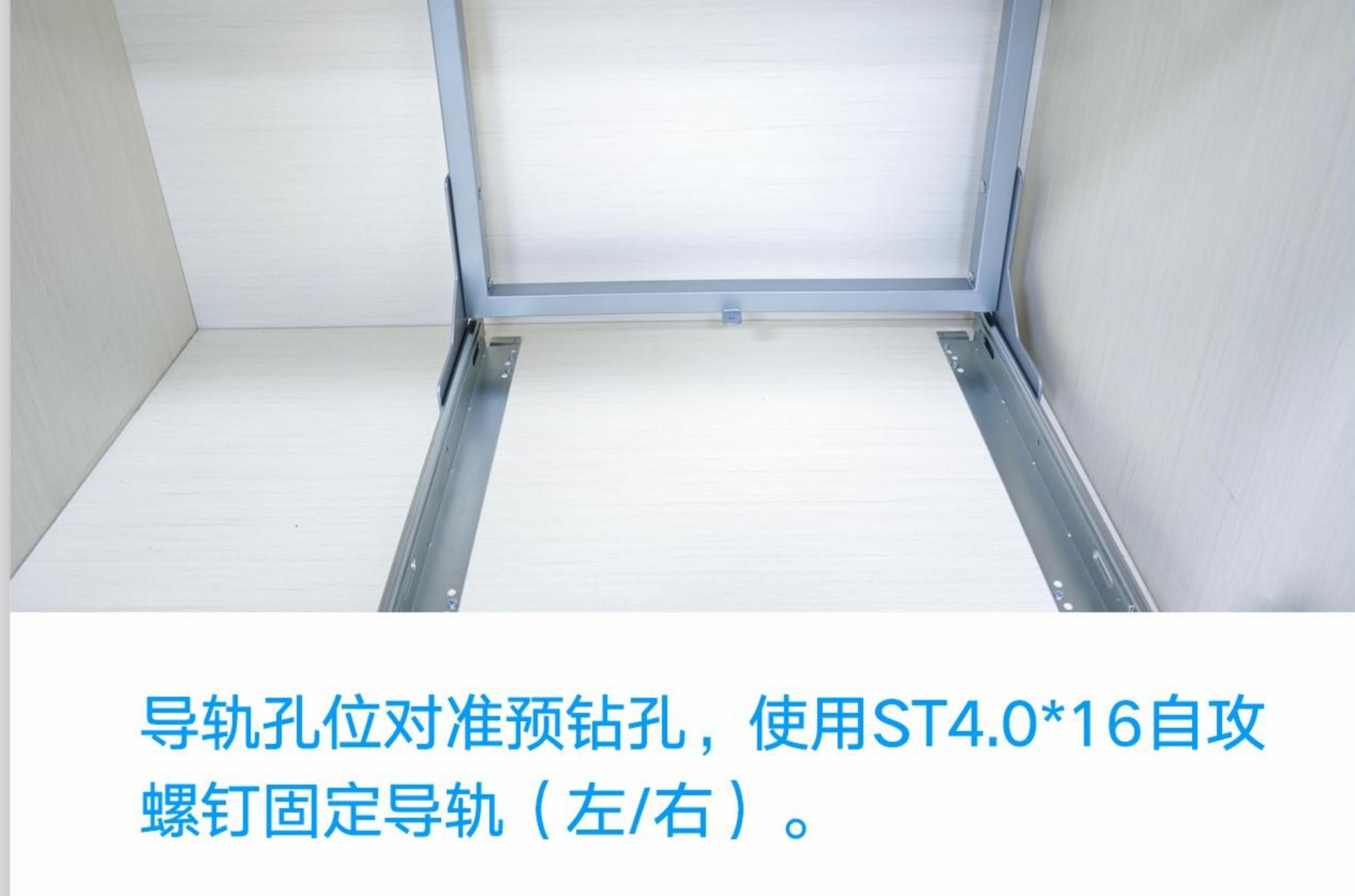
导轨孔位对准预钻孔，使用ST4.0\*16自攻螺钉固定导轨（左/右）。
