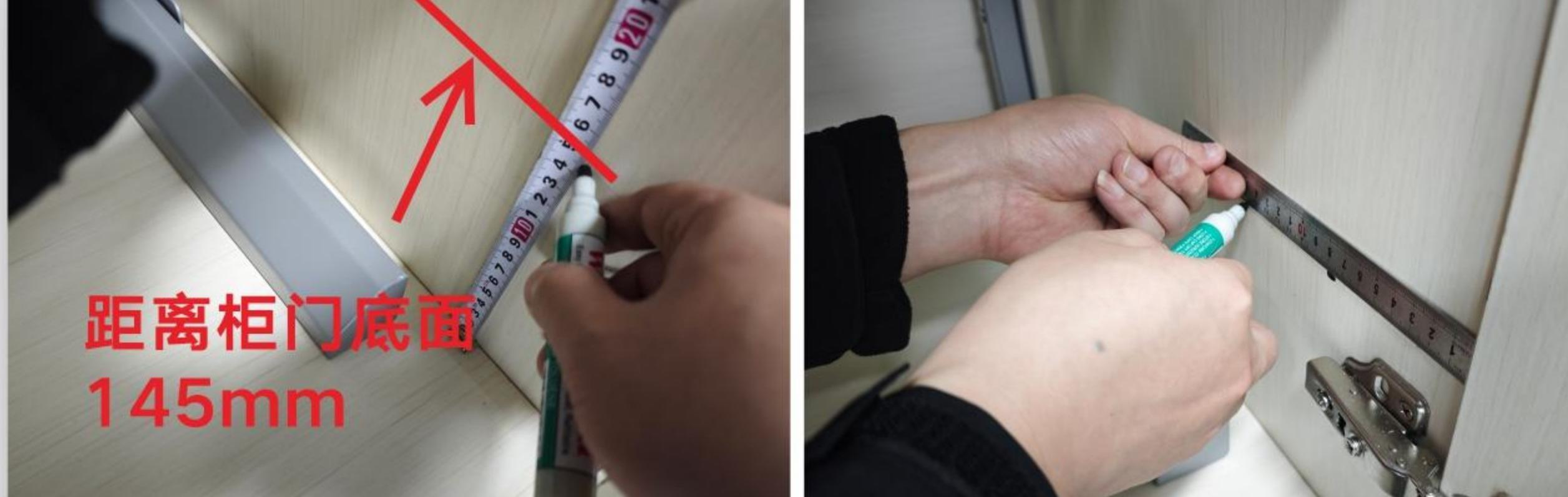
以柜门底面为基准，距离柜底面145mm处画第一条基准线。
