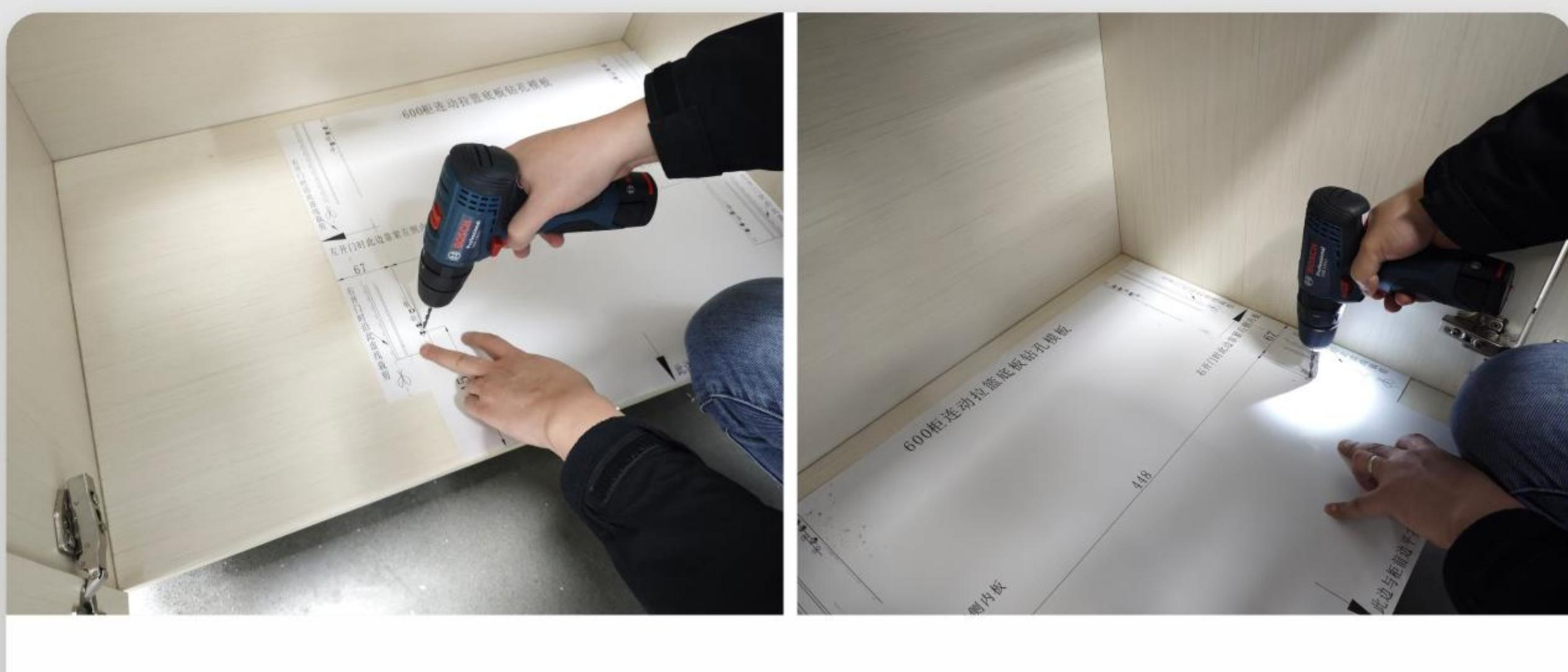
使用安装模版进行预钻孔（注意开门方向）。
